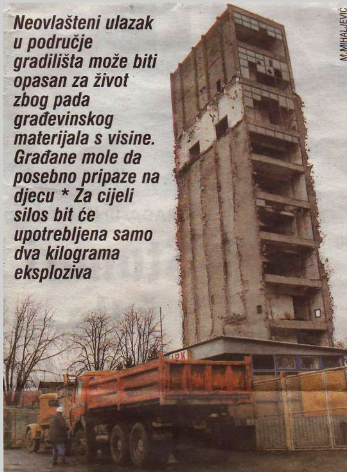
Ve duže vrijeme obavljaju se pripreme za rušenja najvišeg dijela silosa
