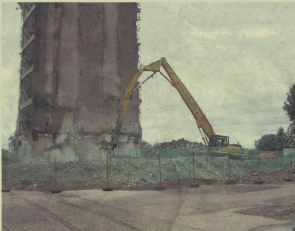
Eurco trenutno u Osijeku ruši silos visok 42 metra, što je tromjesečni zahvat vrijedan oko 350.000 eura
