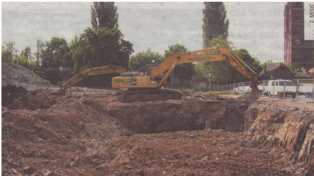
Kapacitet drobilice je 200 tona na sat, a reciklira se i otpad
